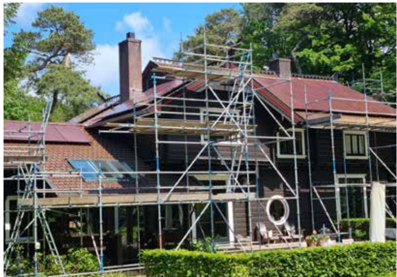
Plaatsing rode zonnepanelen, Huizen
